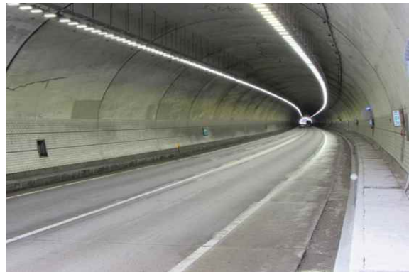
터널 내부 전경
