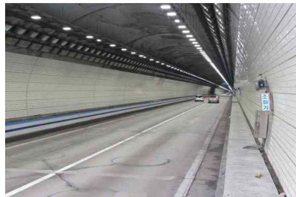
터널 내부 전경
