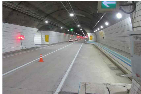
터널 내부 전경
